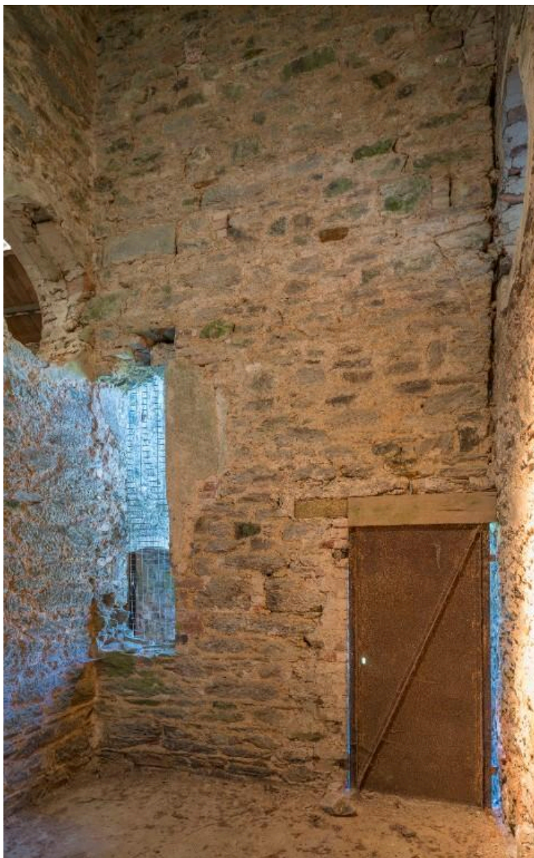
Bâtiment principal. Salle 2. Mur nord-ouest avec porte d'entrée
