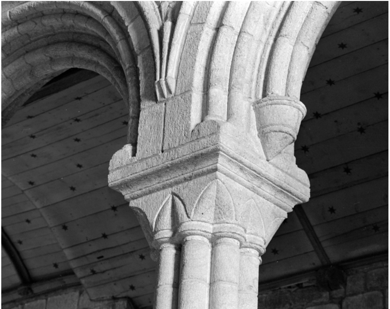
5e pile sud, vue nord-ouest
