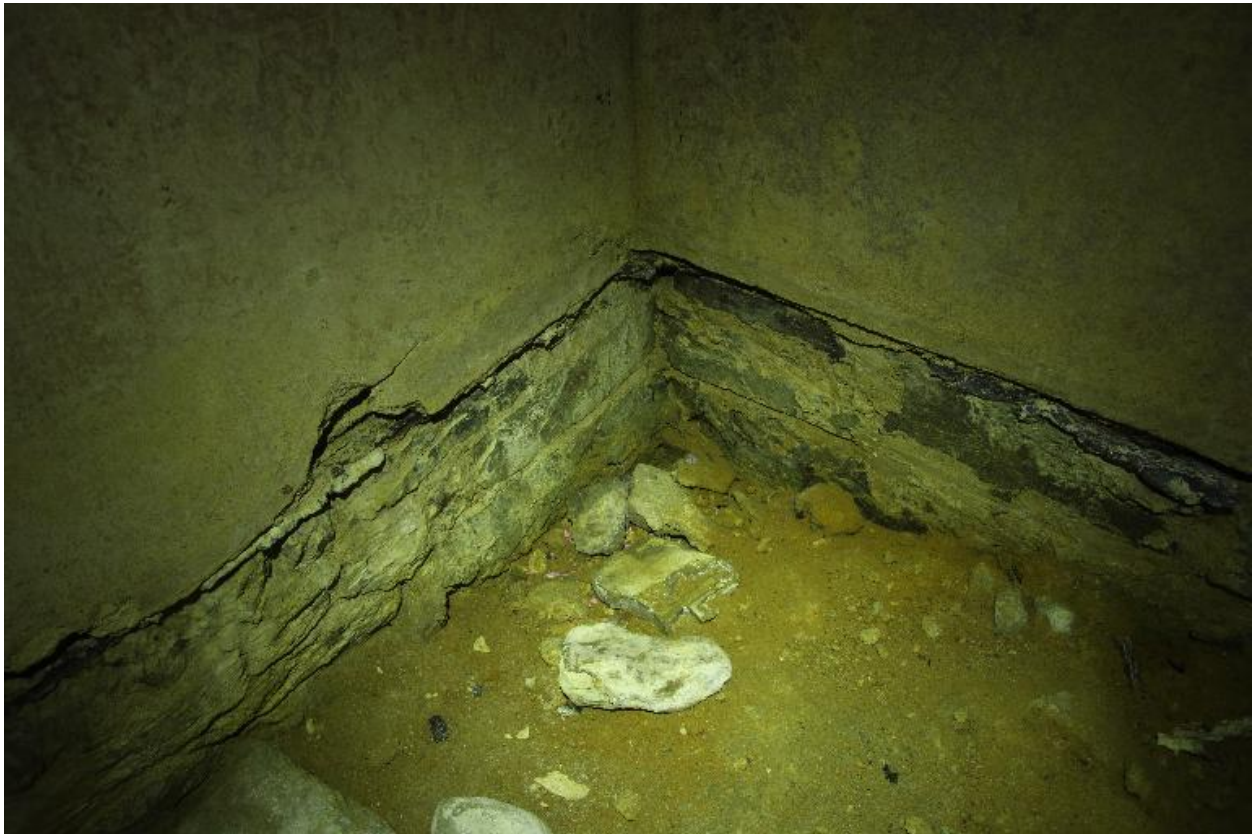
Locmaria, Grands Sables, batterie de La Ferrière, corps de garde crénelé, magasin à poudre, détail du vide sanitaire.
