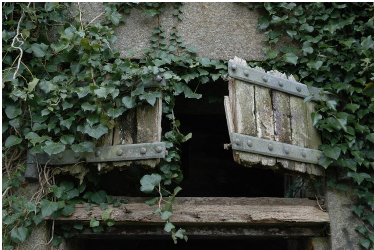
Vue d'un magasin à poudre : huisseries et volets en bois (état en 2005)
