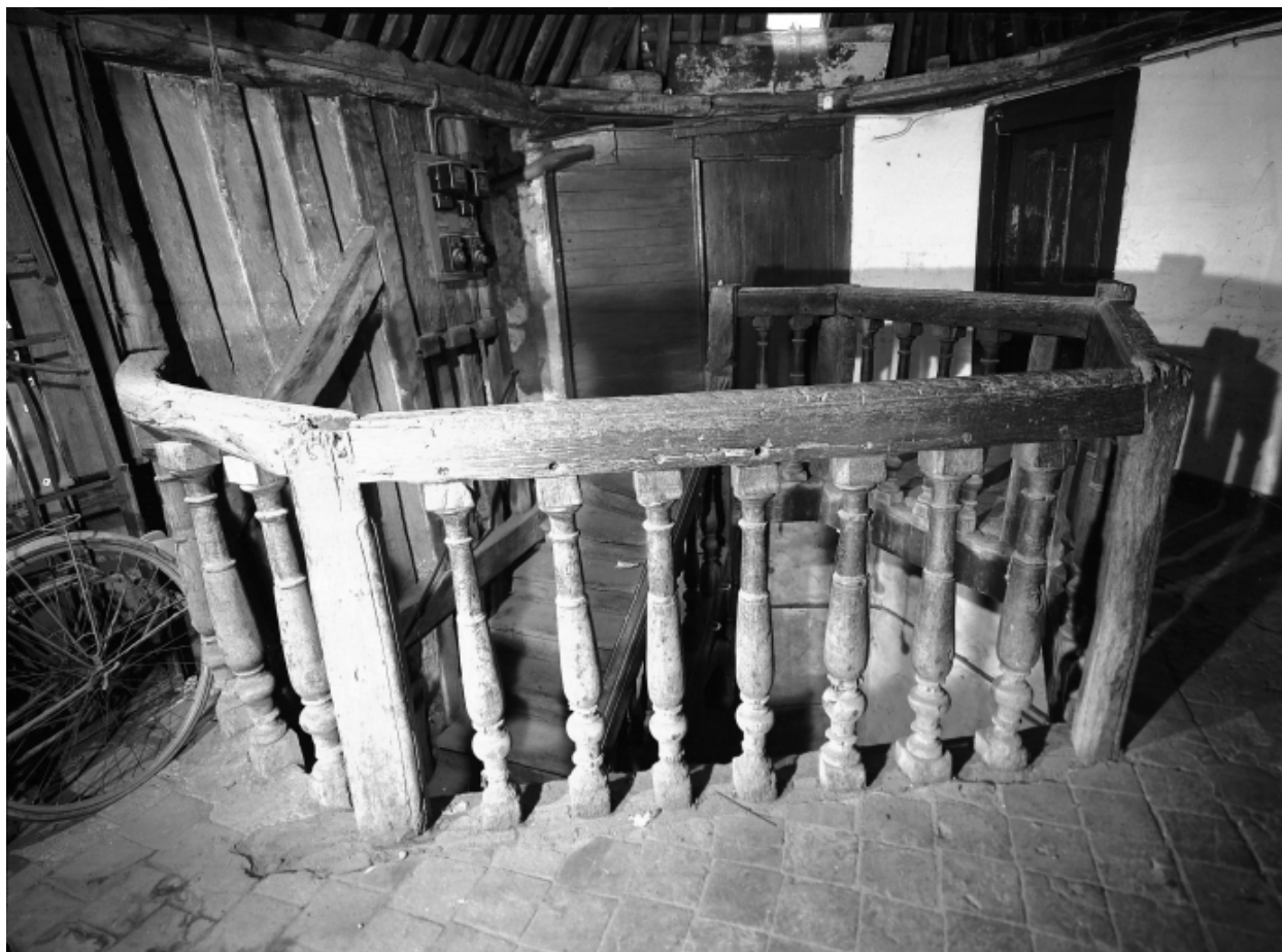
Escalier : vue du troisième étage
