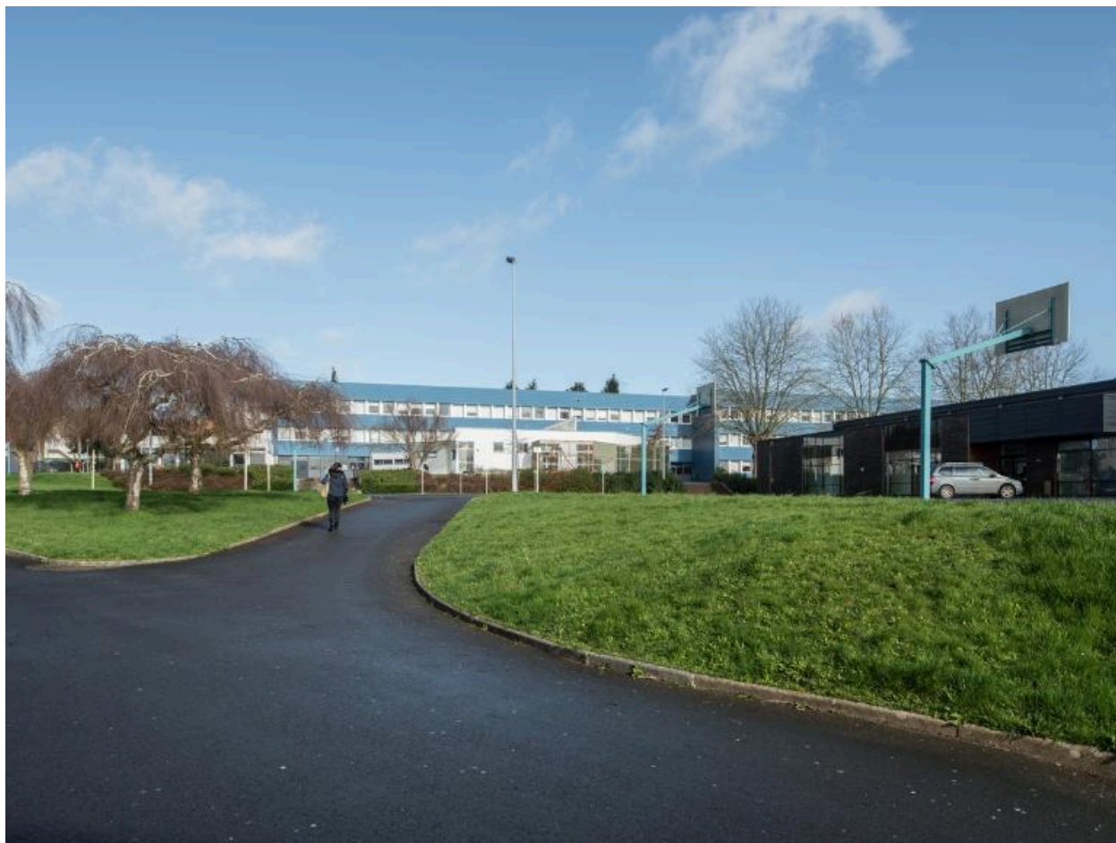
Vue d'ensemble : externat et, à droite, gymnase (Albert Hec et Roger Besnard, architectes, 1966). Au centre, CDI (Bernard Kaleski, architecte, 1992).
