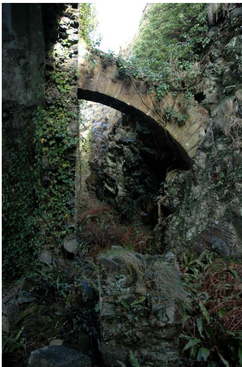
Vue de la caserne défensive Robert : façade postérieure, arc-boutant
