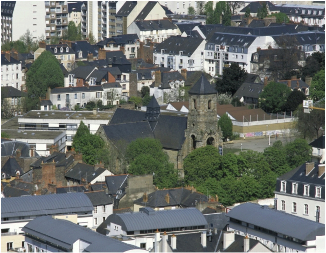
Vue de situation prise du sud-ouest
