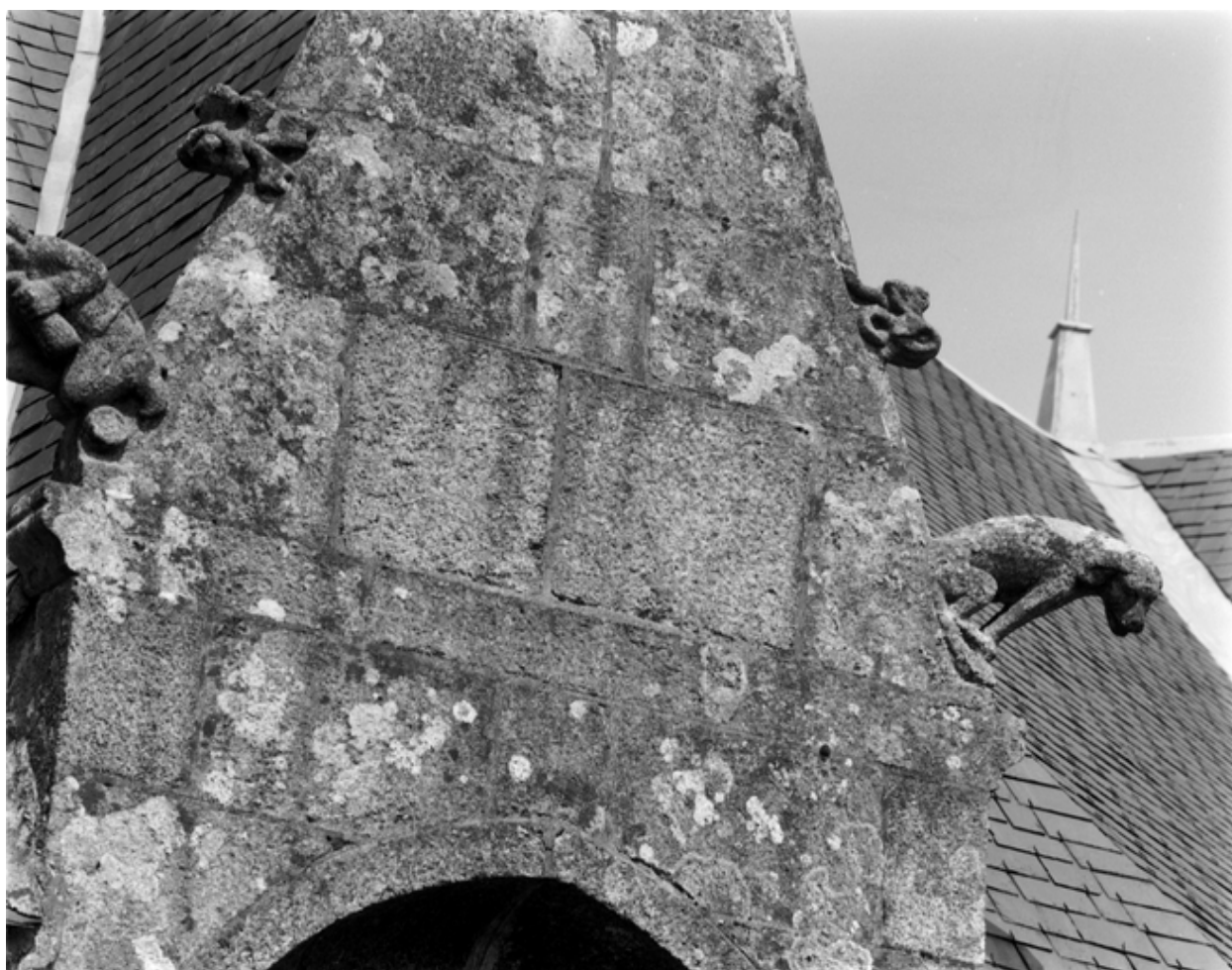
Pierre d'assise du pignon sud est du chevet
