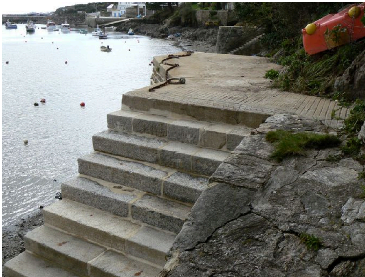
Partie supérieure de l'appontement
