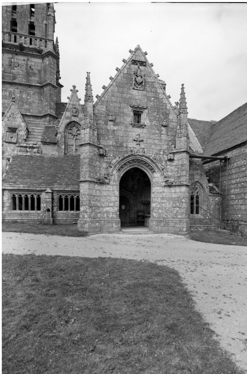
Façade sud, porche : vue générale
