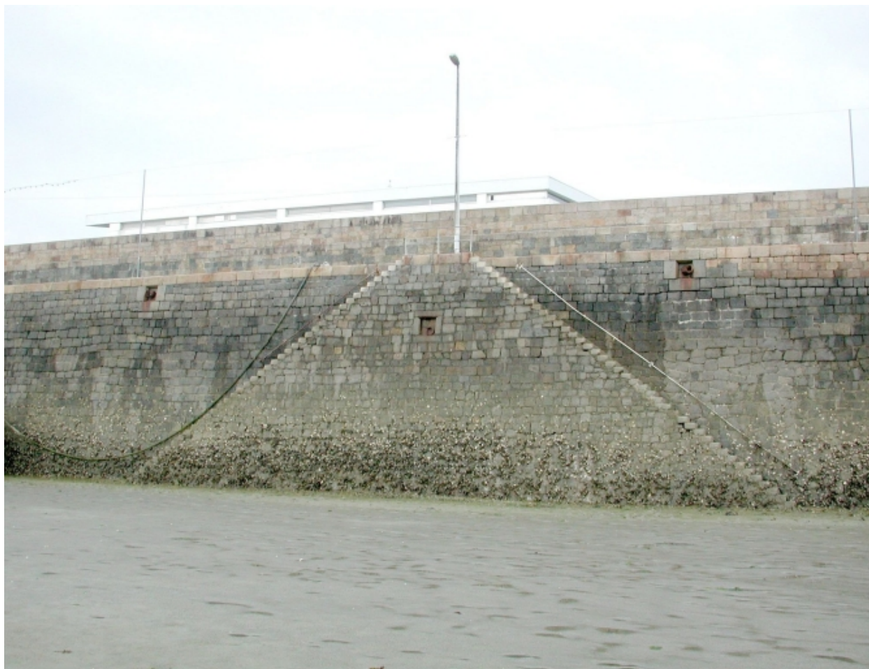
Vue des escaliers
