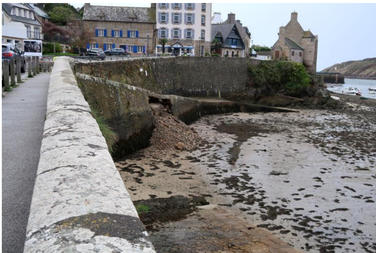
Parapet du quai et cale ouest du Drellac'h
