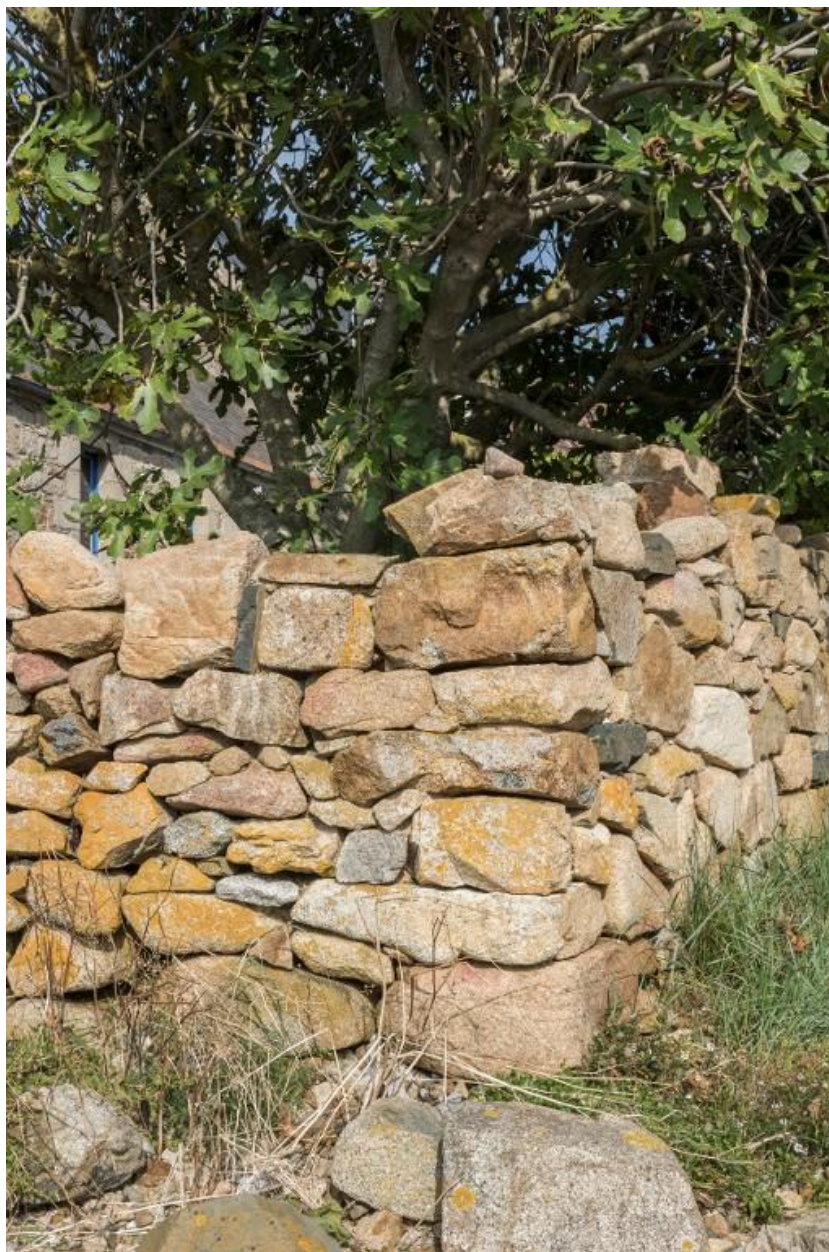
Muret de clôture faisant un angle droit, au niveau de l'anse de Pelinec
