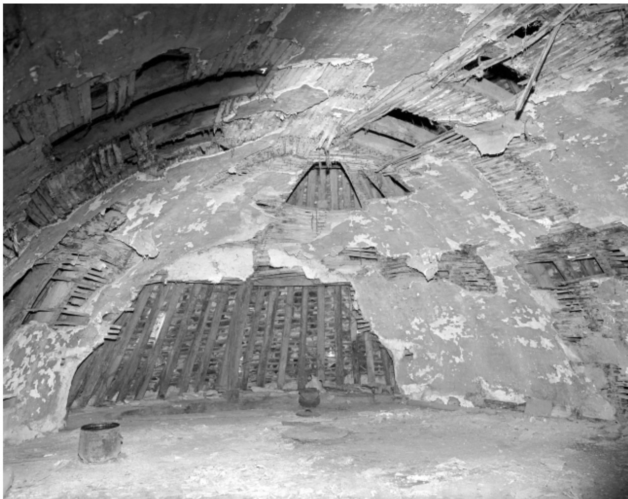
Détail arc de charpente.
