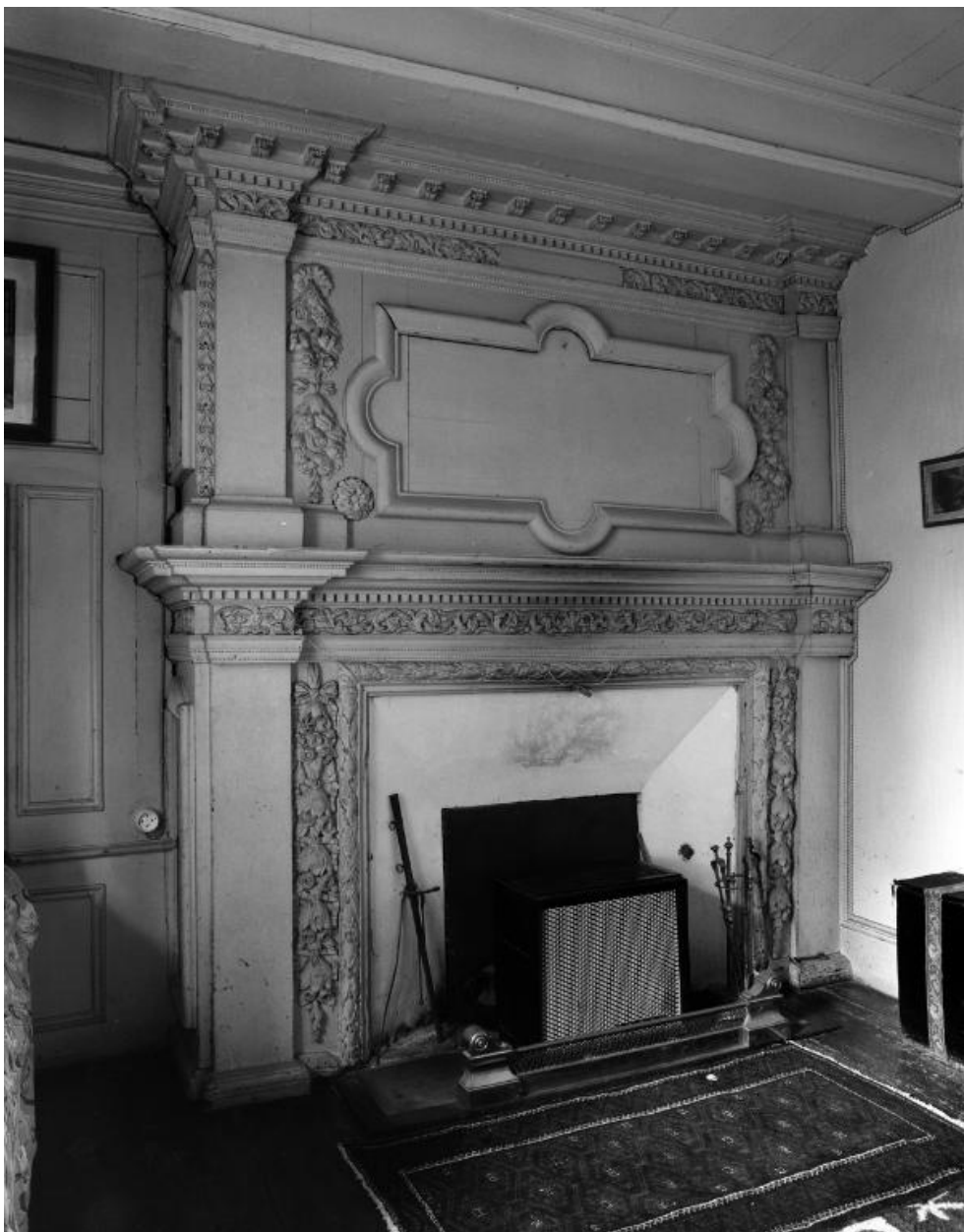
Corps central, étage, cheminée, vue générale
