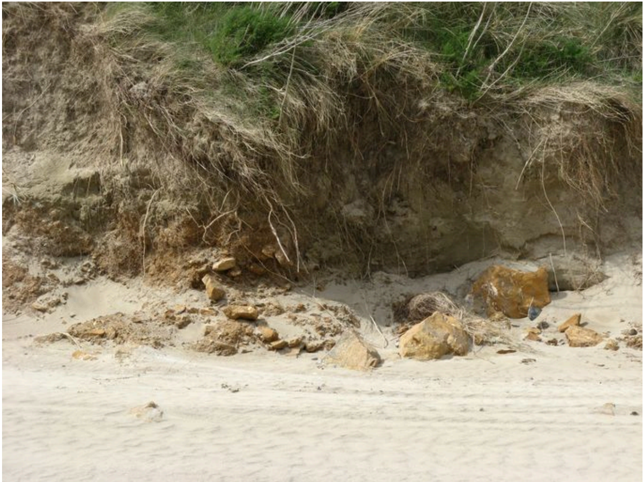
Vue générale des vestiges de la digue Richet
