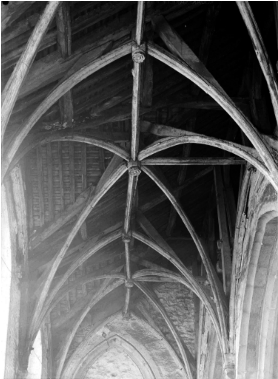
Charpente du collatéral sud
