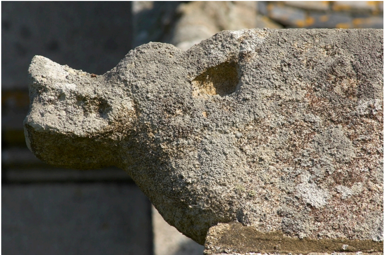
Détail d'une crossette de pignon.
