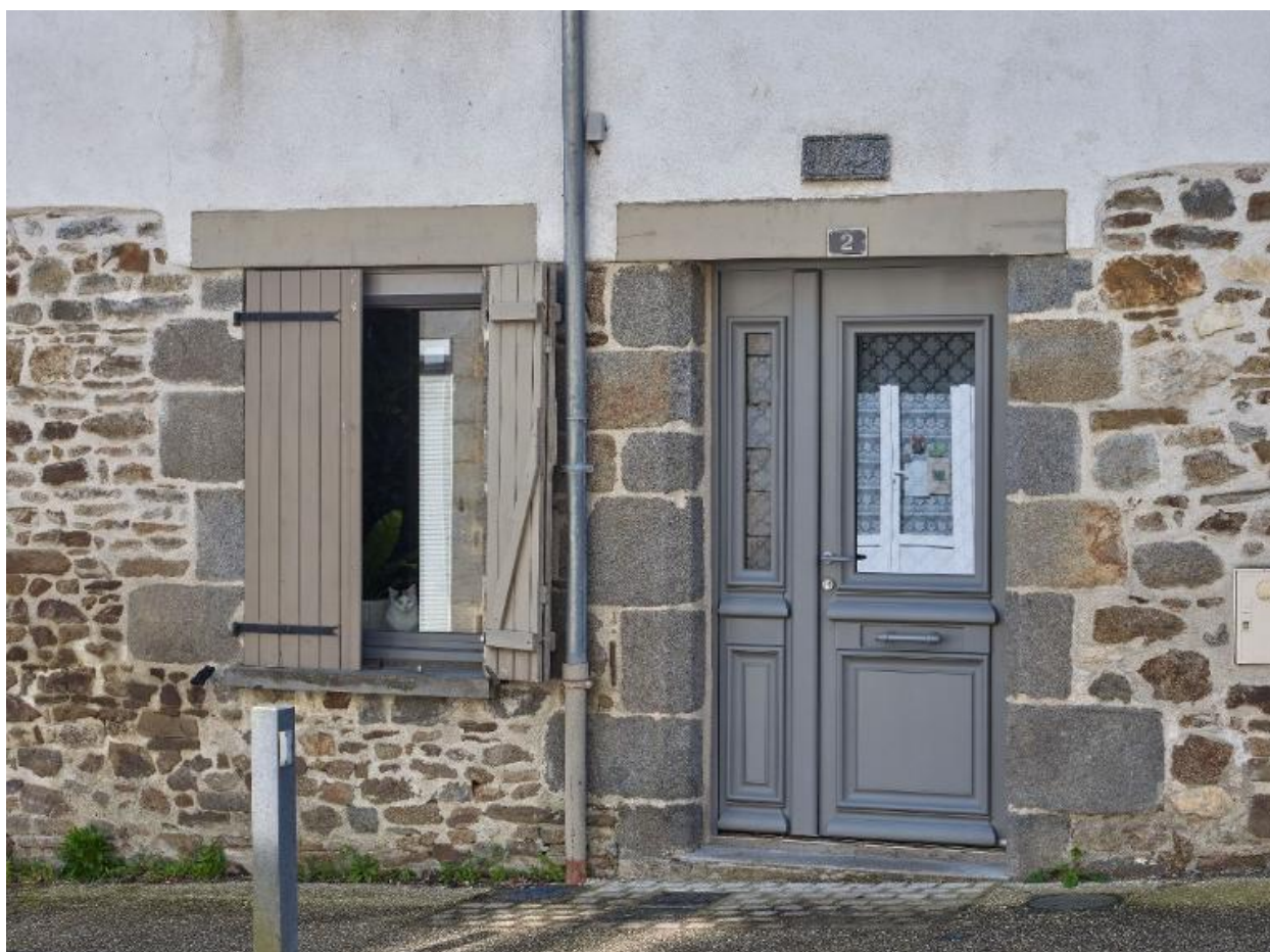
Elévation antérieure, détail des ouvertures du rez-de-chaussée.
