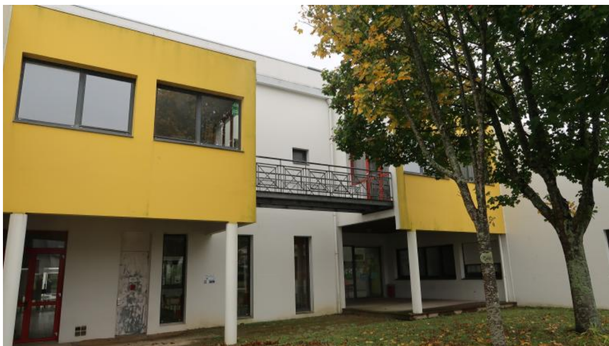
Détail de la façade ouest, entre l'espace professeurs et les services de restauration (F).
