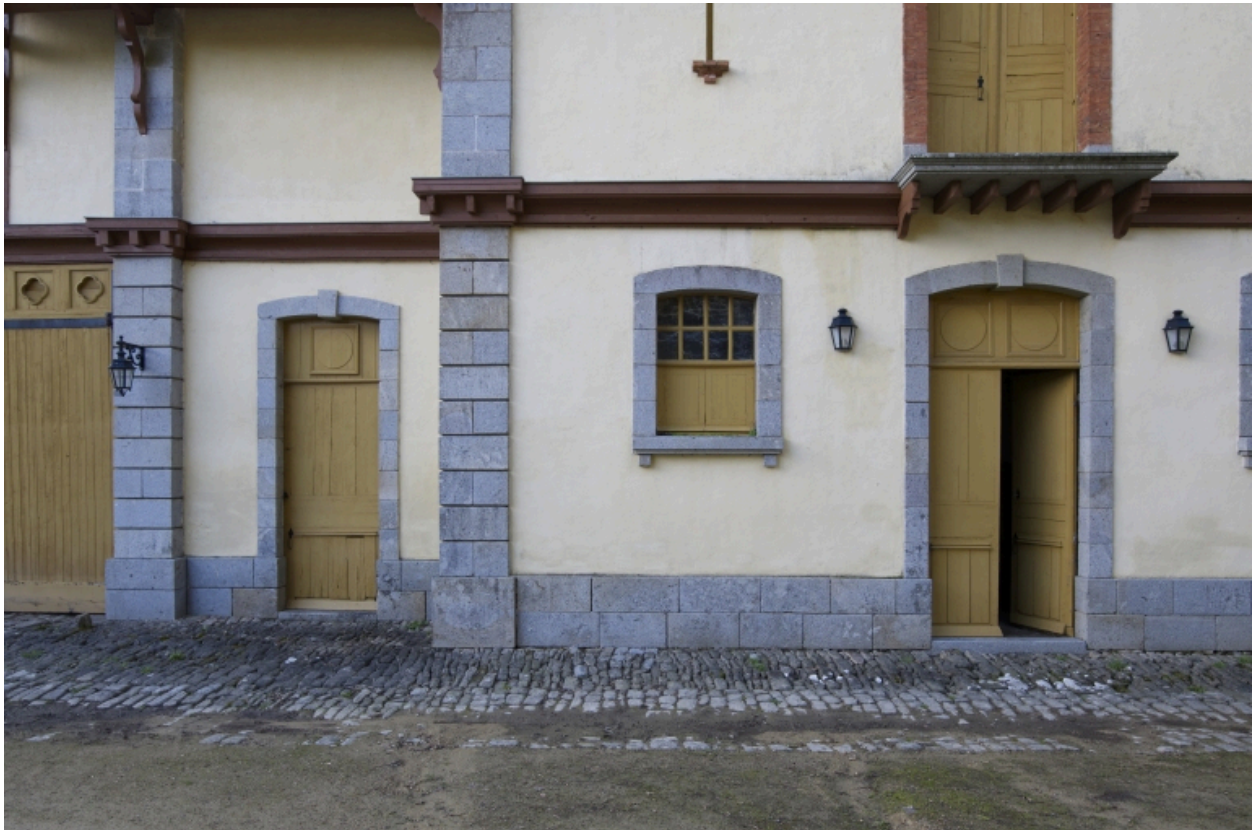
Communs, élévation est, détail des ouvertures
