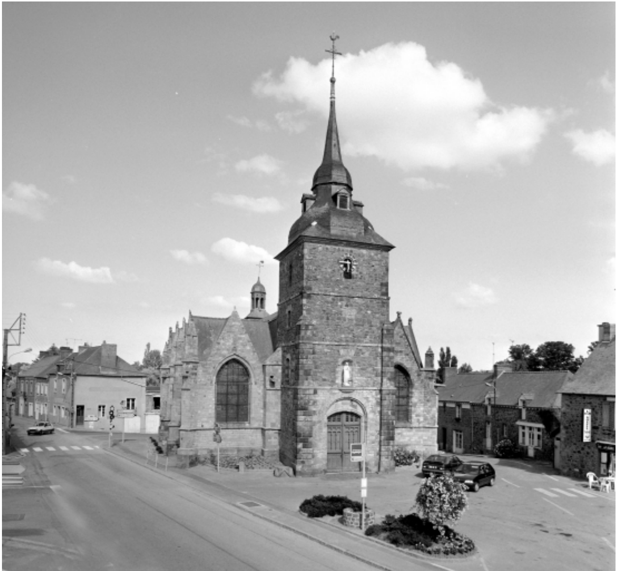
Elévation Ouest : vue générale
