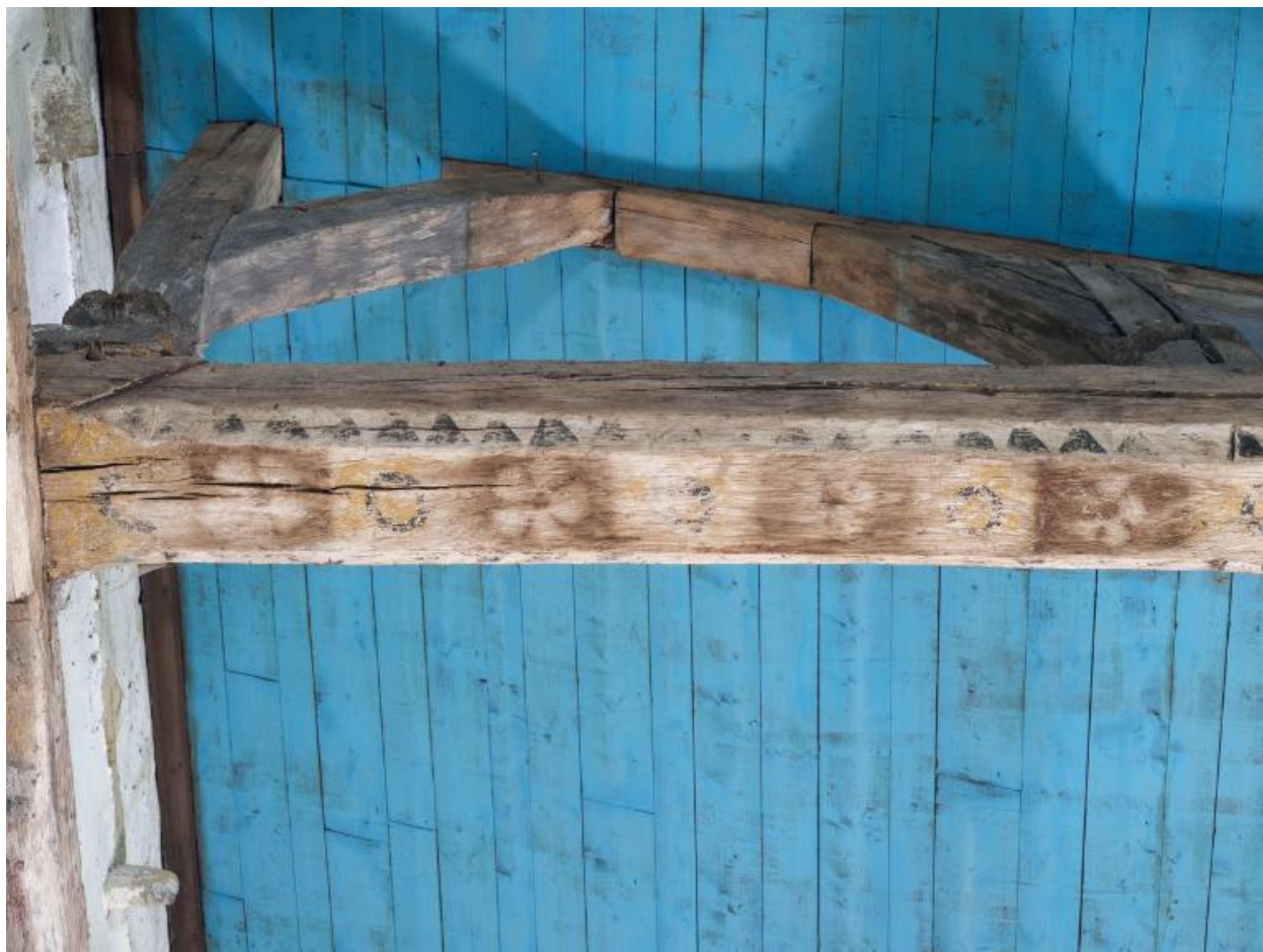
Charpente du bas côté sud : entrain à décor de fleurs et de cercles
