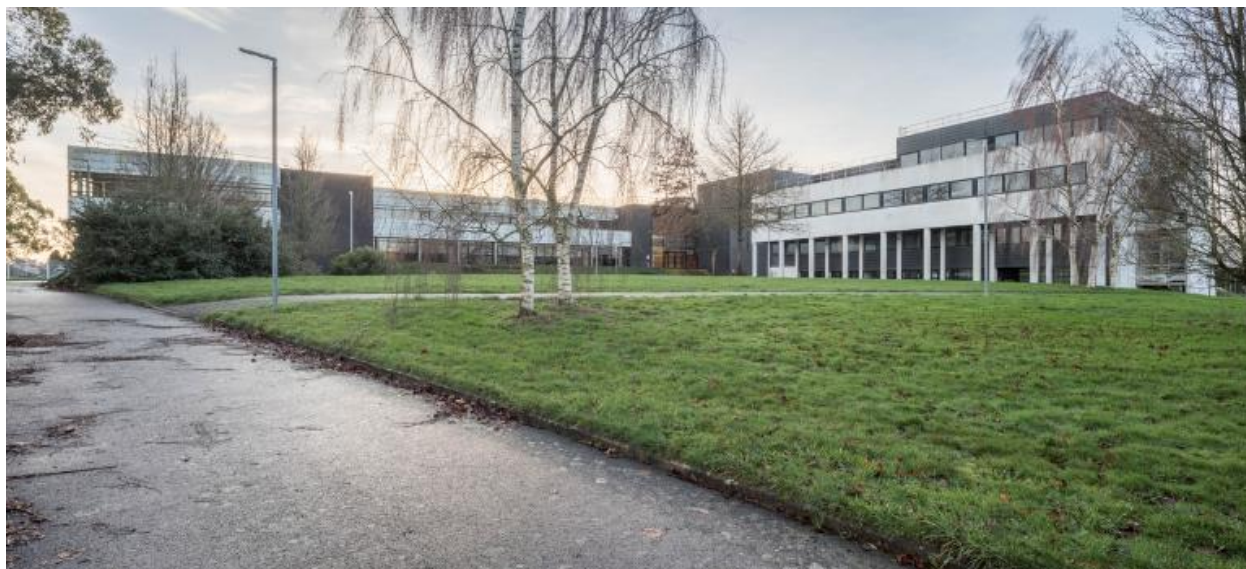
Vue prise du nord-ouest des façades du bâtiment multifonctions. Philippe Brulé et Marc Quéré, architectes, 1997.
