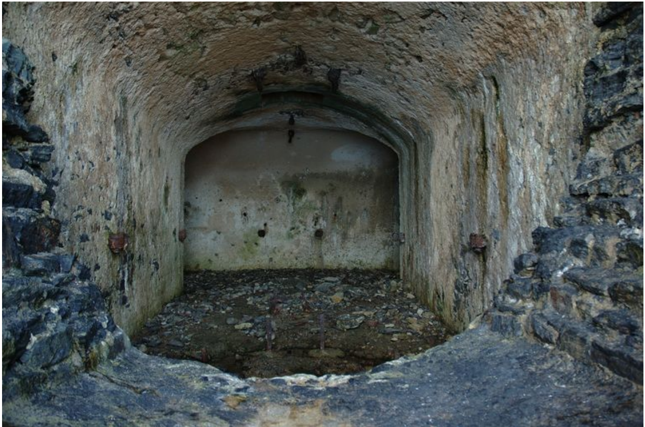
Vue de détail de l'embrasure est (état en 2007)
