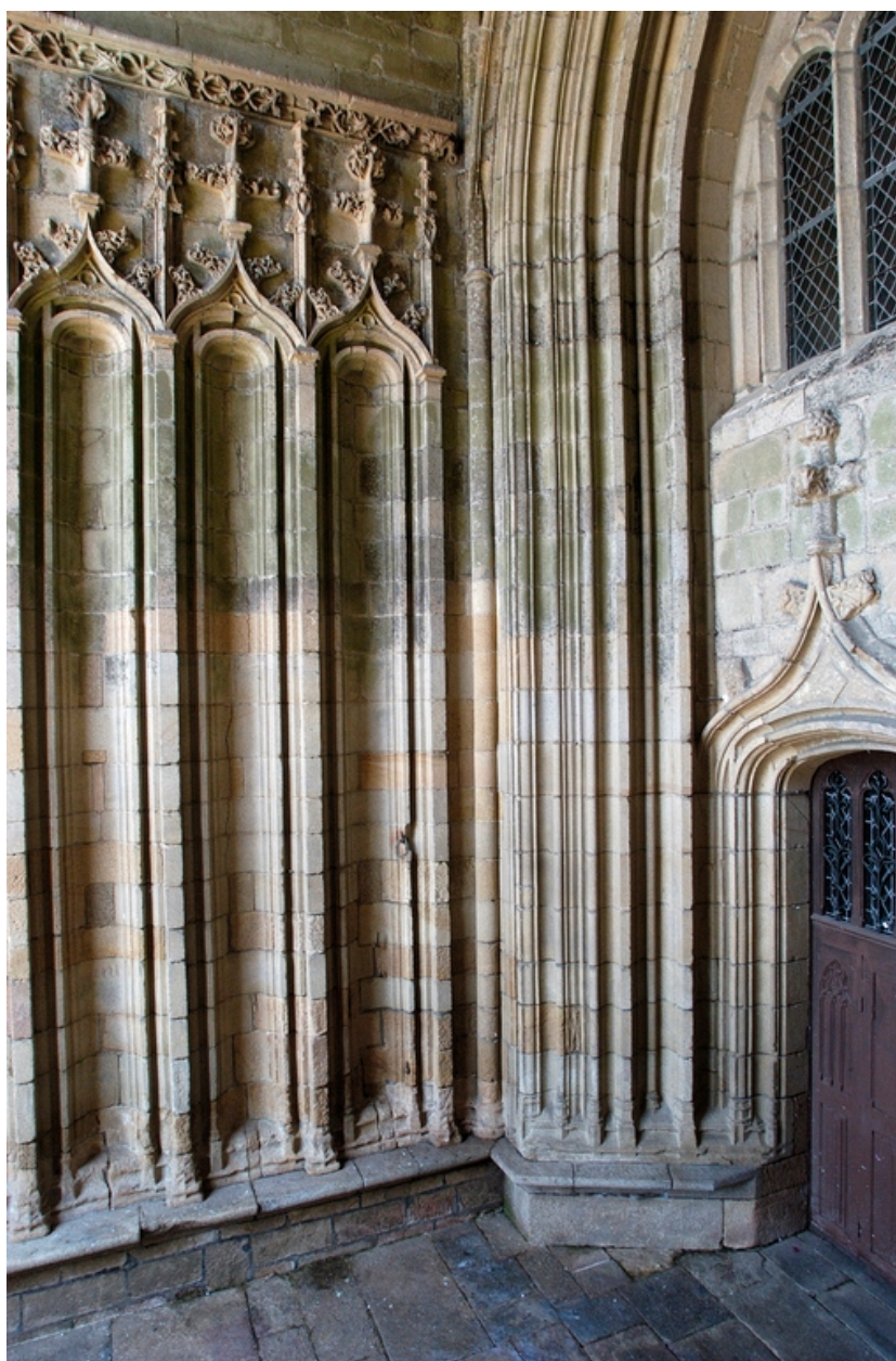
Porche ouest, raccord des arcatures des parois avec le portail ouest
