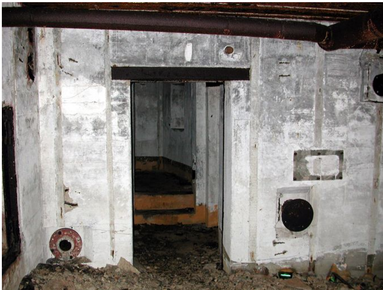
Vue intérieure : entrée de la salle de garde/pièce de vie (état en 2003)
