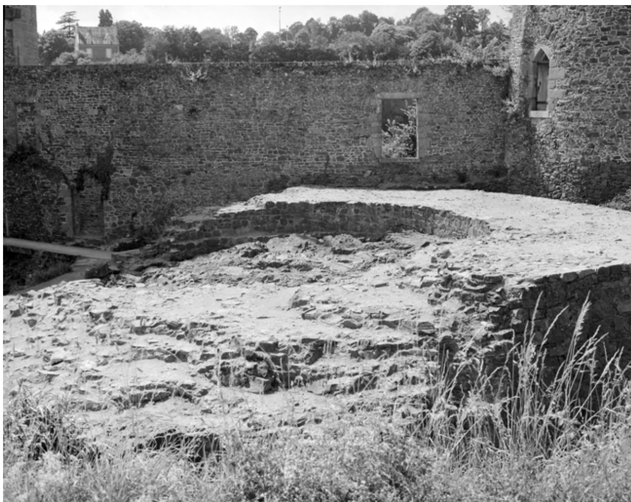
Ruines du donjon, vue au sol.
