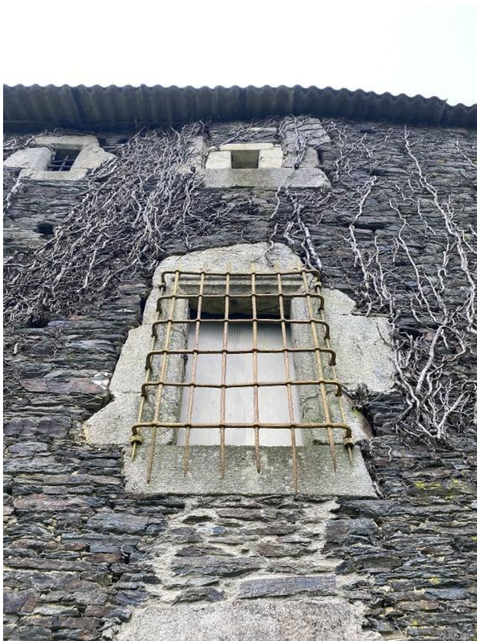
Élévation est, détail
