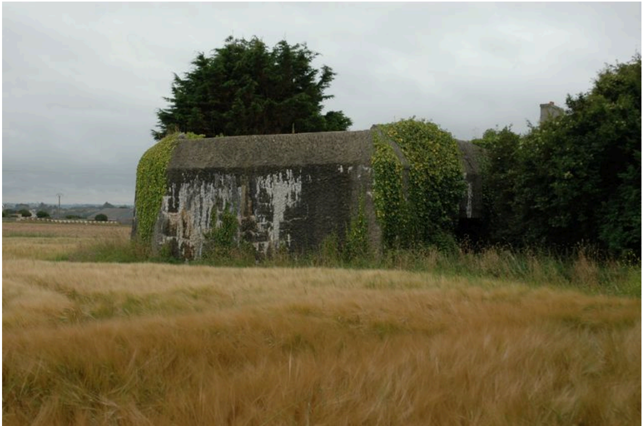
Vue de l'une des quatre casemates de type 669 (état en 2008)
