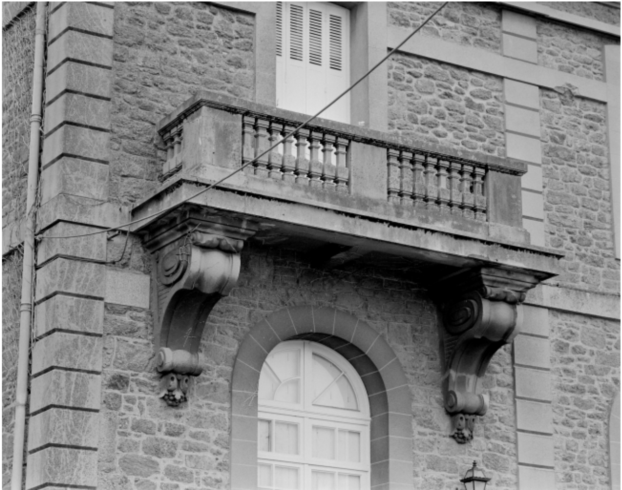
Vue de la façade antérieure sud, détail du balcon.
