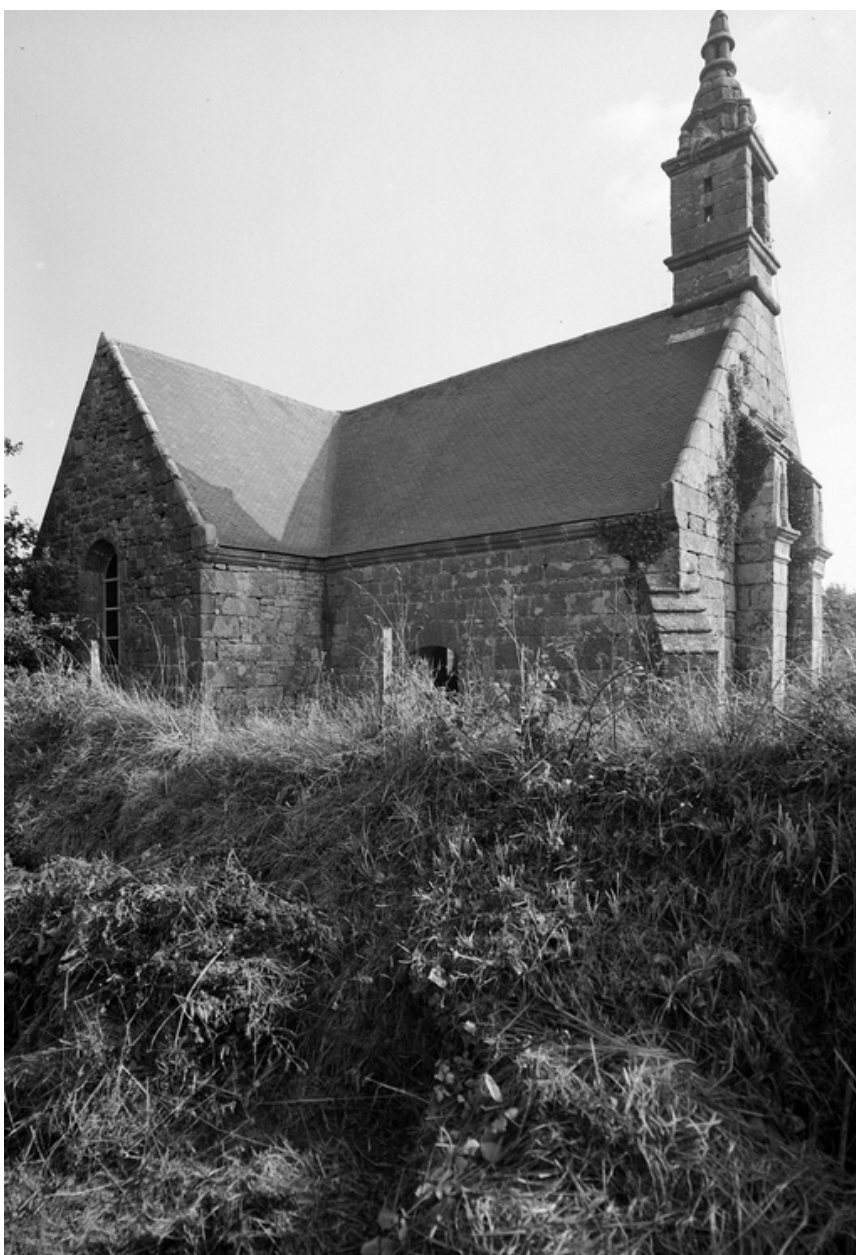
Vue de la façade nord
