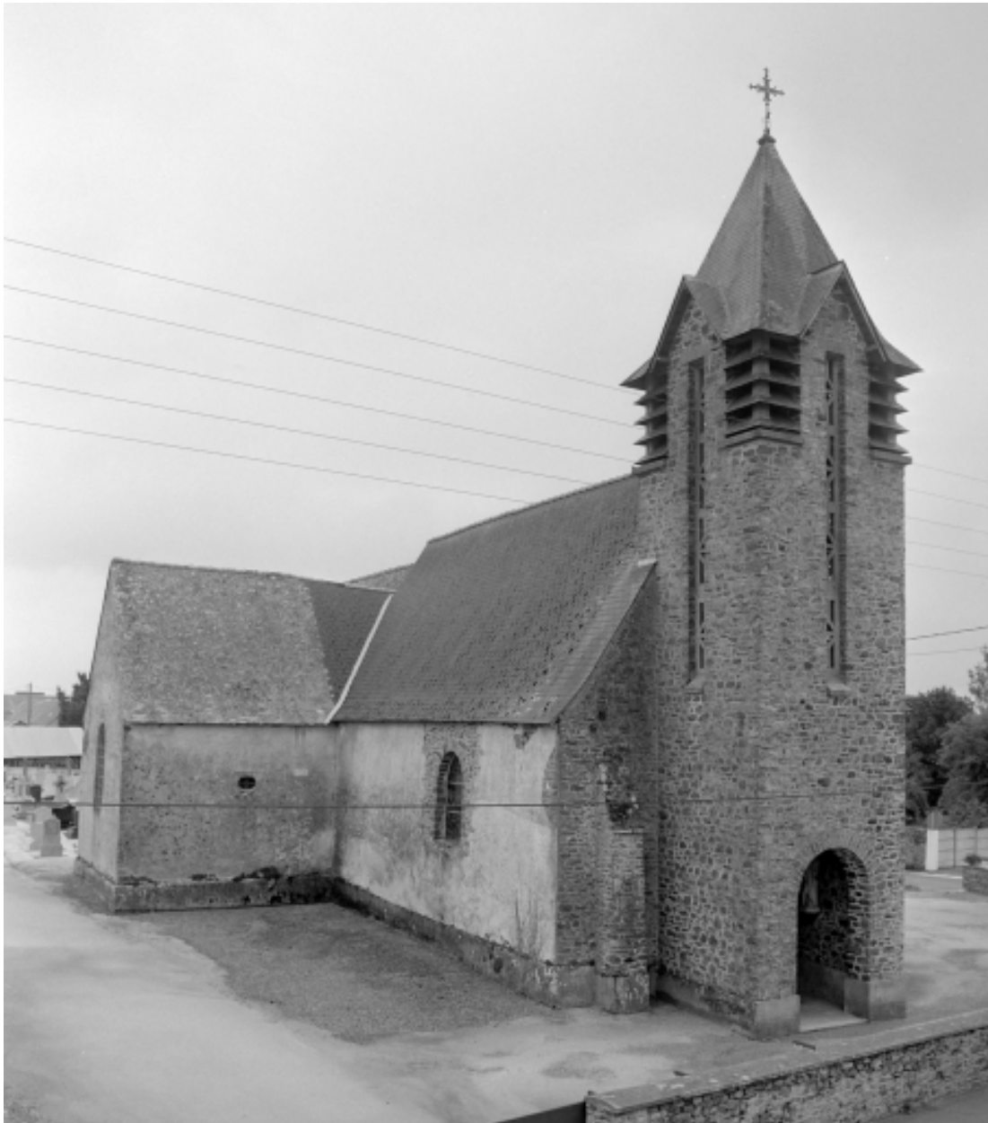
Elévation nord-ouest : vue générale
