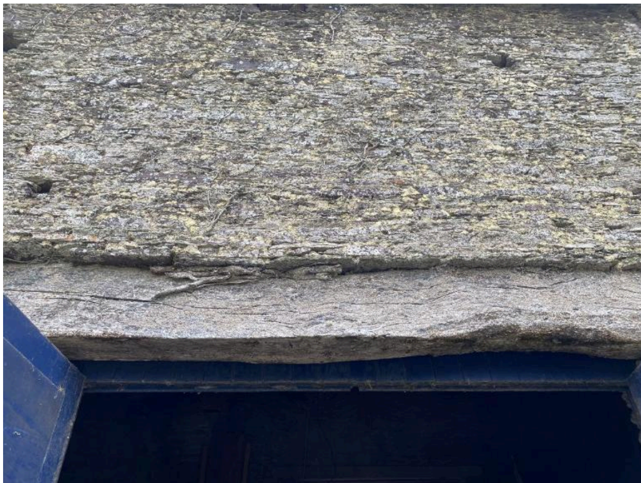
Larmier, aile nord, élévation nord
