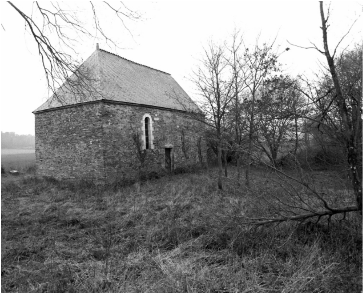
Elévation nord-est : vue générale
