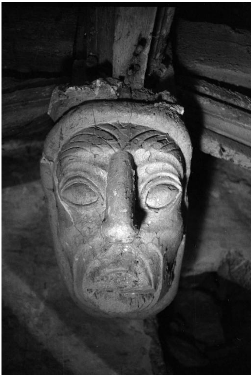
Charpente, détail de la clé 31.
