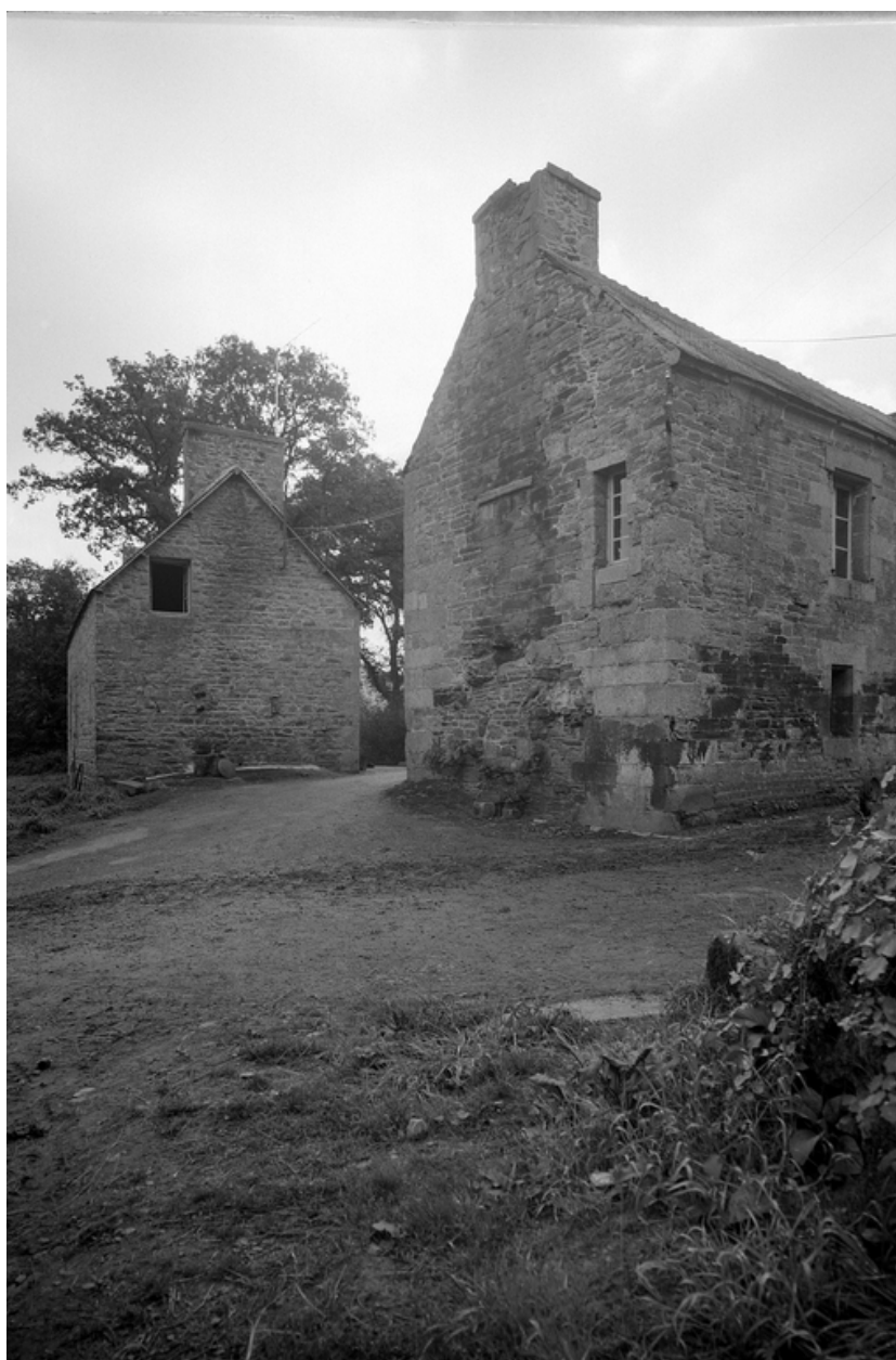
Vue de situation prise du nord-ouest
