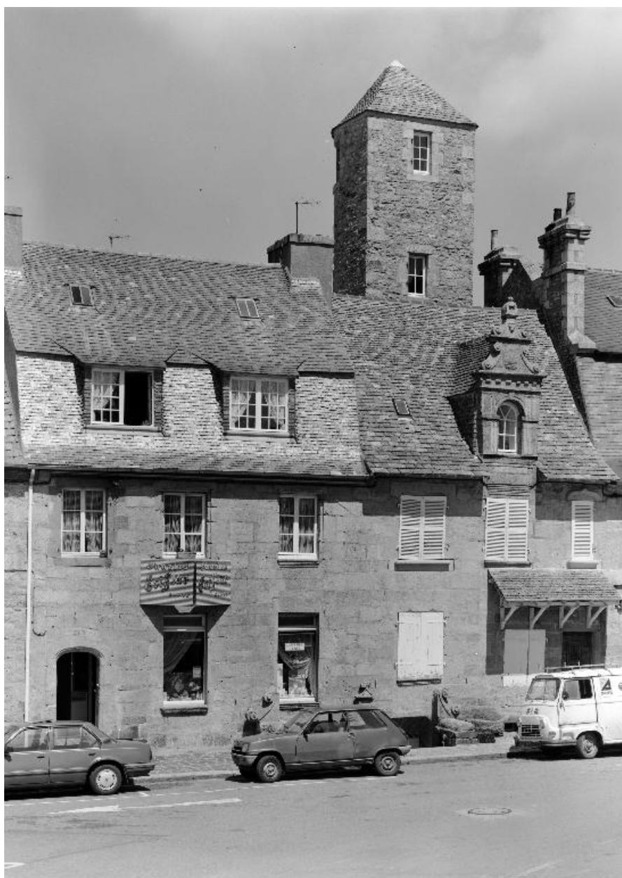
21-23 place Lacaze-Duthiers, élévation sud, vue générale
