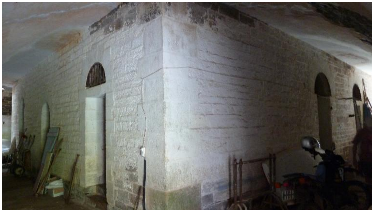
Le Palais, batterie du Gros Rocher, corps de garde crénelé, angle nord-ouest.
