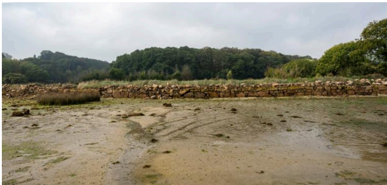
Vue d'ensemble d'un mur de soutènement, sur la rive ouest de l'anse de Pelinec
