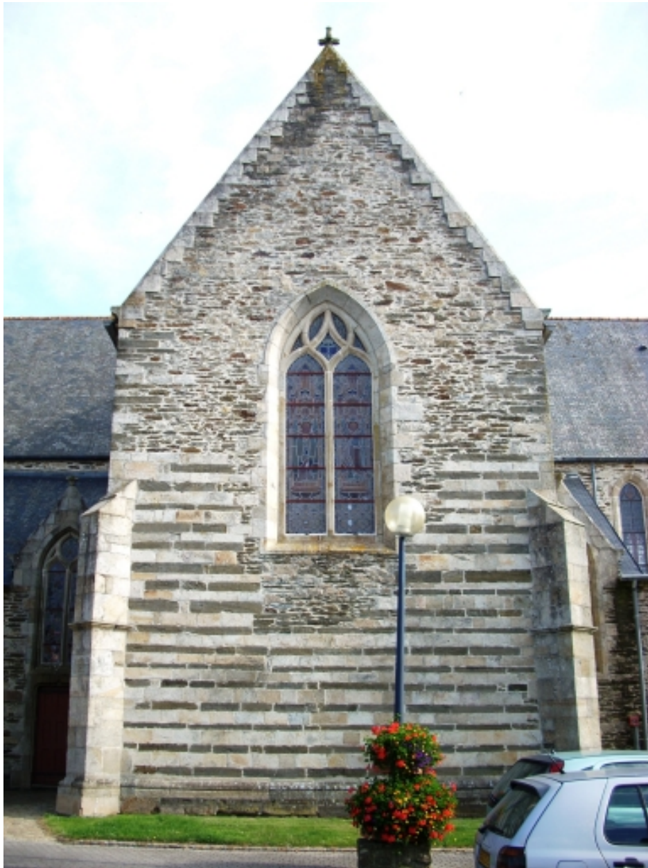
Plouvorn, église paroissiale Saint-Pierre : bras sud du transept, détail
