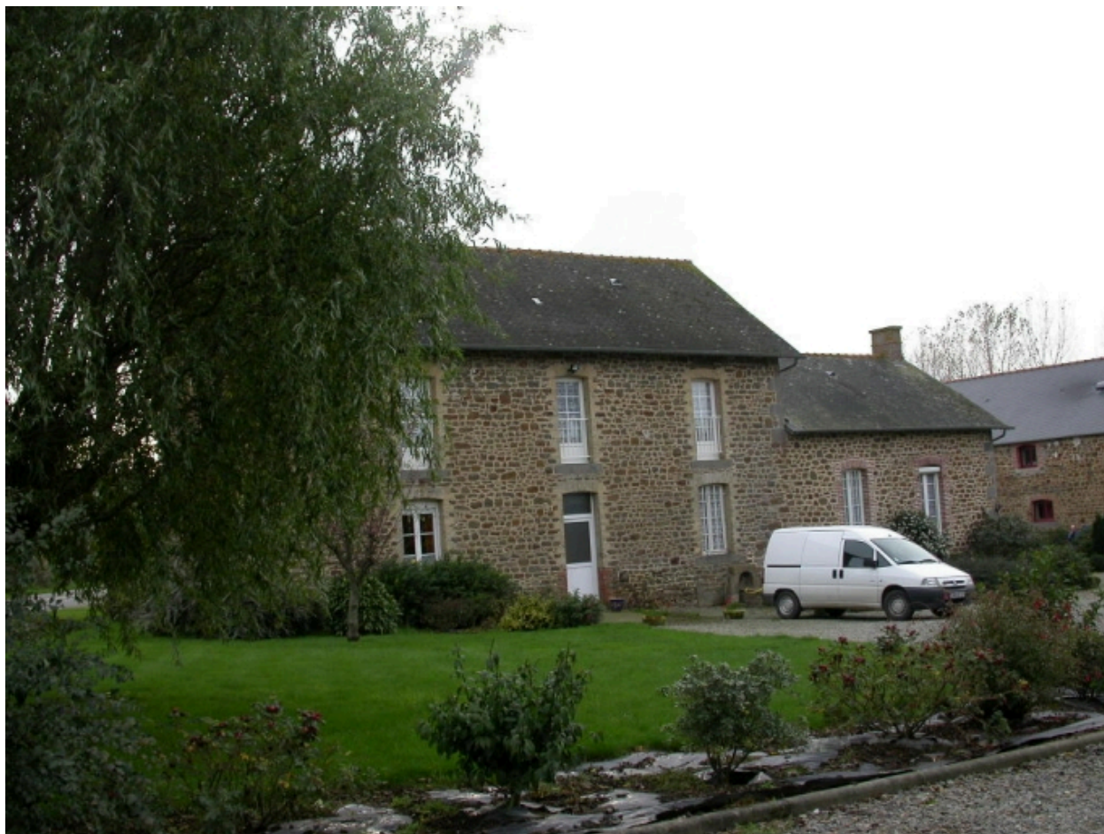
Le logis, façade nord
