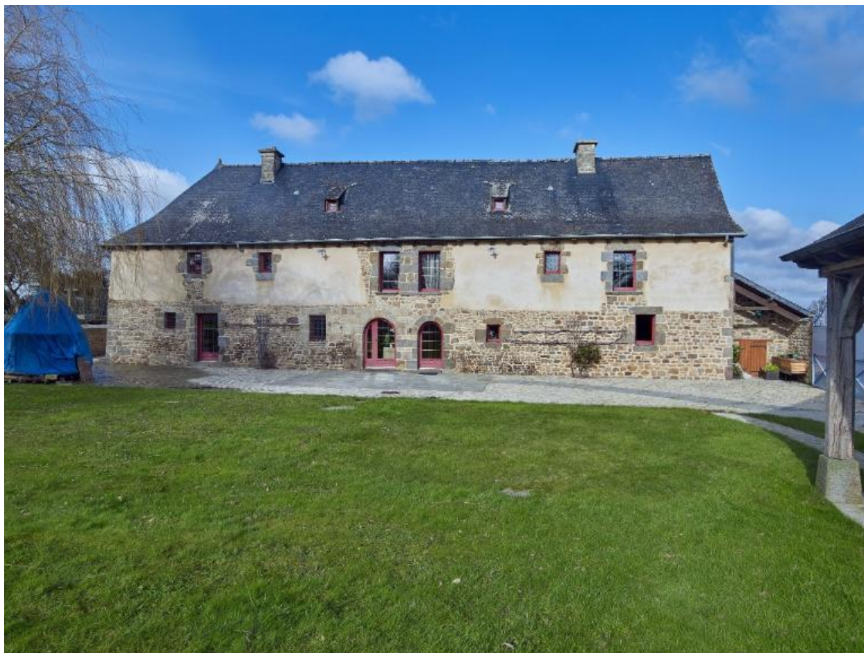
Vue générale sud
