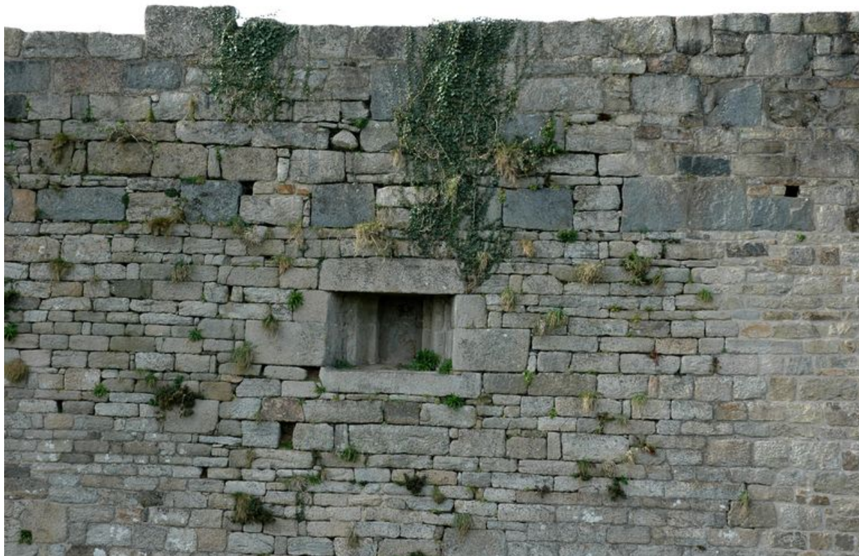
Vue de l'enceinte fortifiée du château de Kerjean
