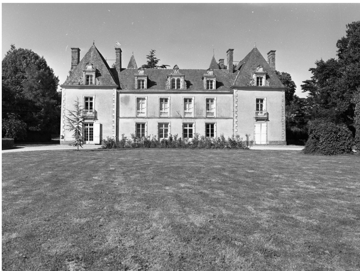
Le logis : vue générale sud
