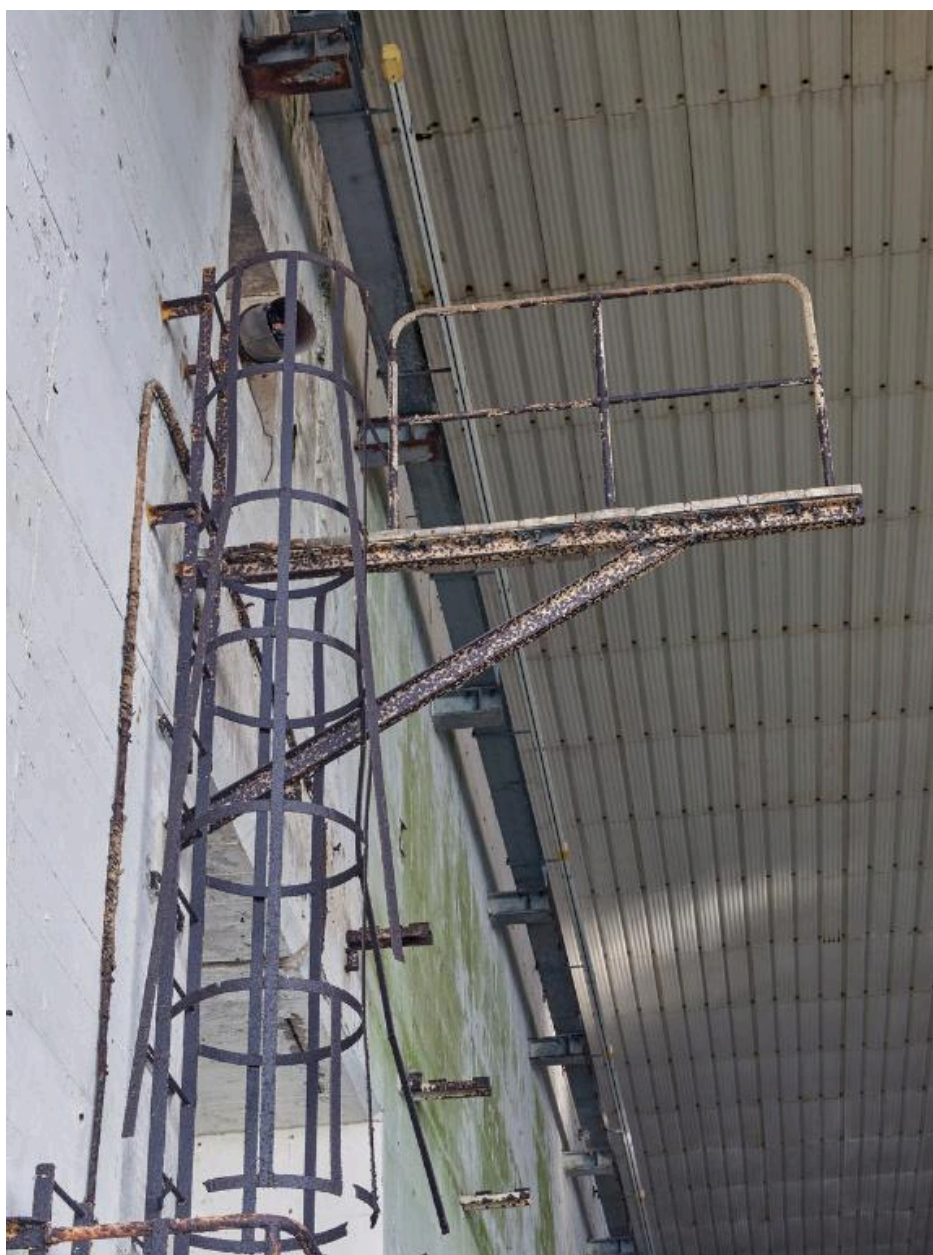
Vue de l'entrée de l'alvéole E (n° 17 et 18) : quai ouest n° 18, plate-forme avec accès par une échelle, projecteur (une paire) dirigé vers les portes d'écluse
