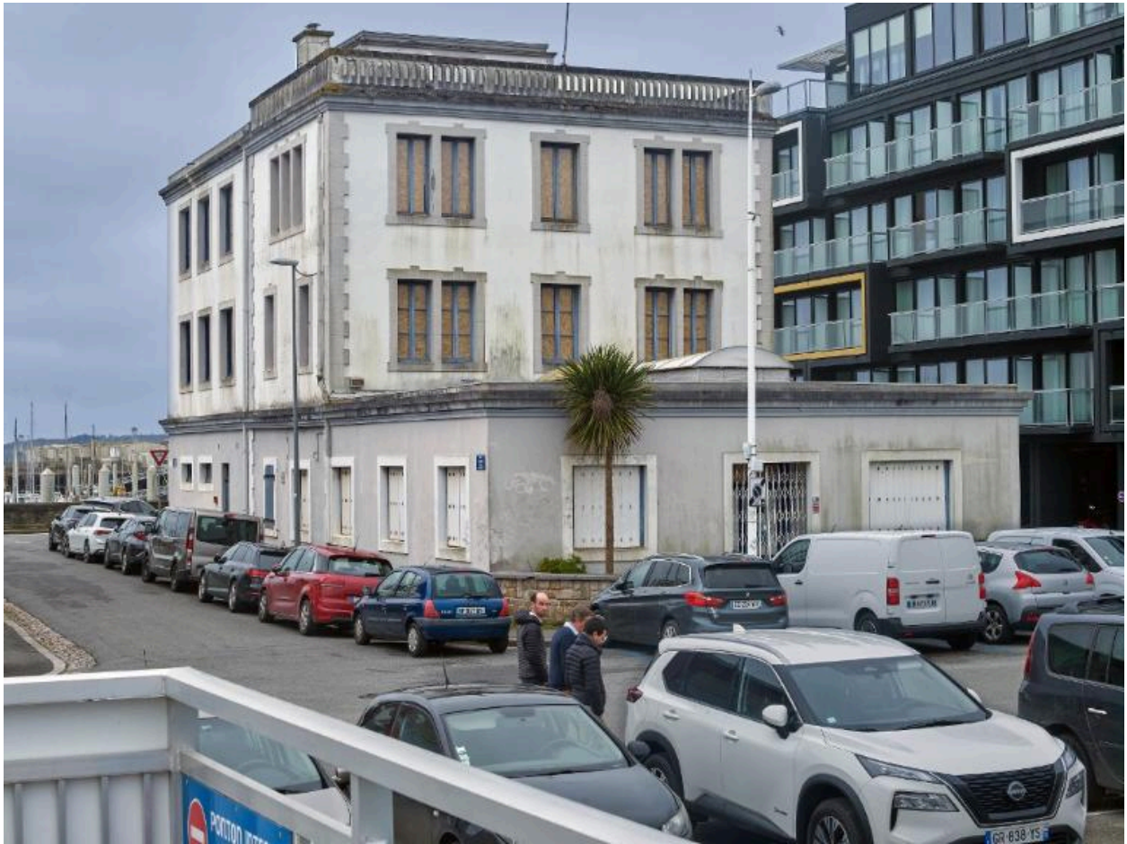
Ancien bureau du port, élévations sud et est
