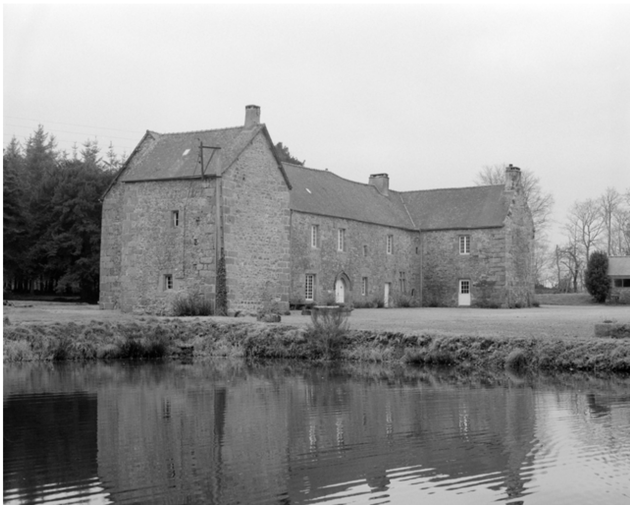
Logis : vue générale prise du nord-ouest.
