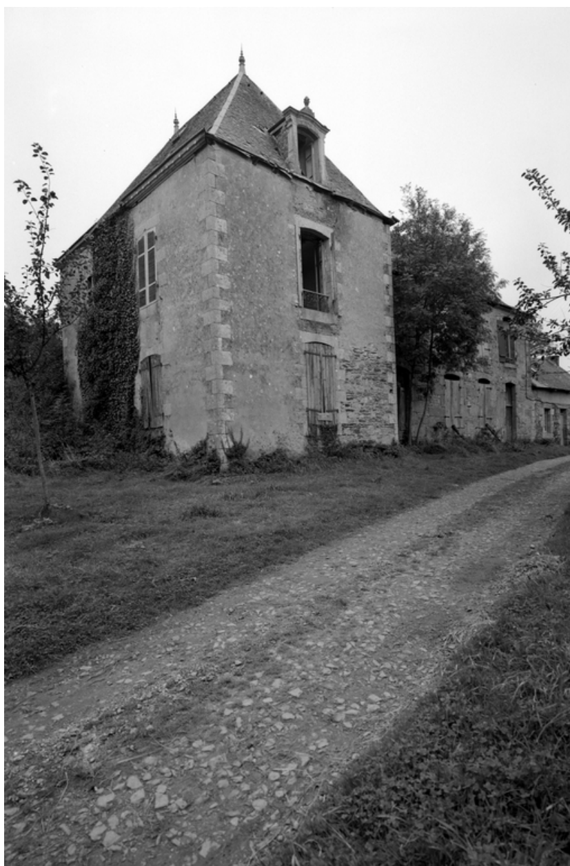
Vue générale nord ouest
